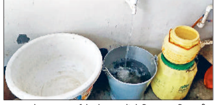
झज्जर। पेयजल सप्लाई के दौरान नलें से निकलता दूषित पानी।
